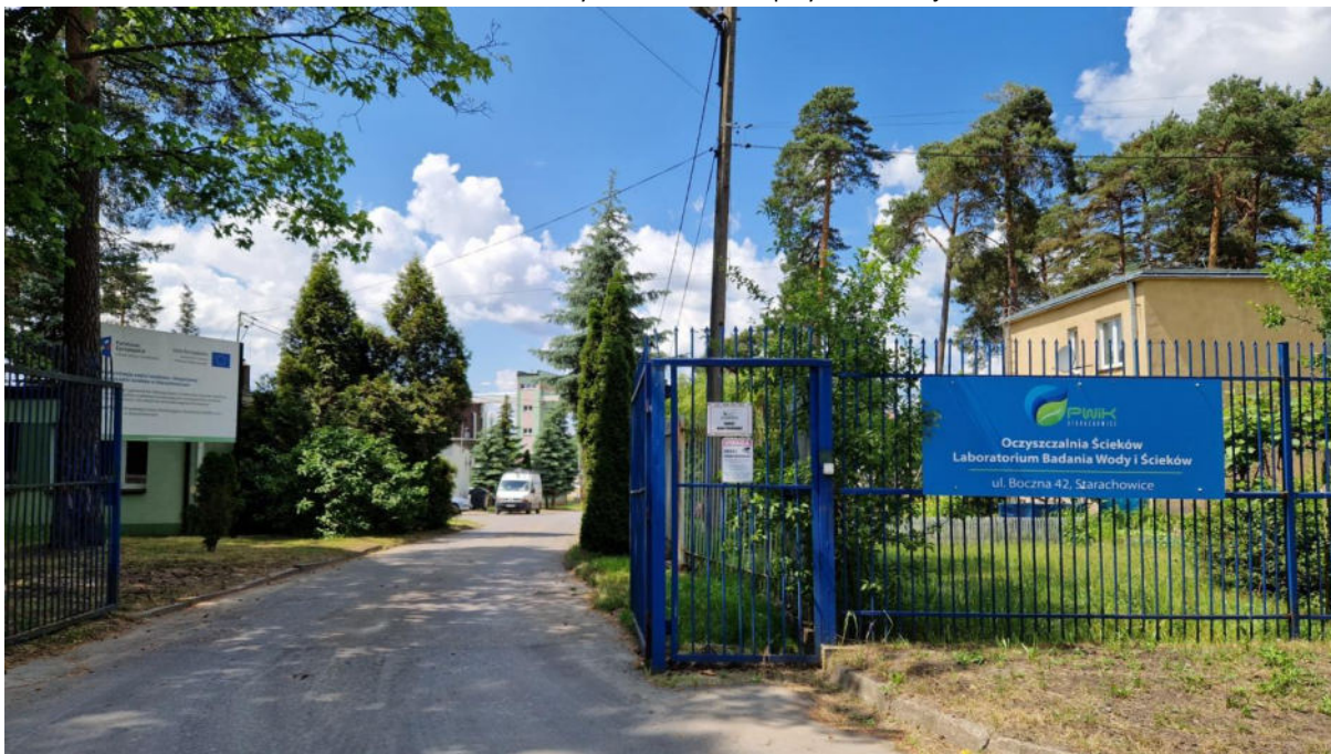
Fot. 4. Teren oczyszczalni ścieków przy ul. Bocznej
