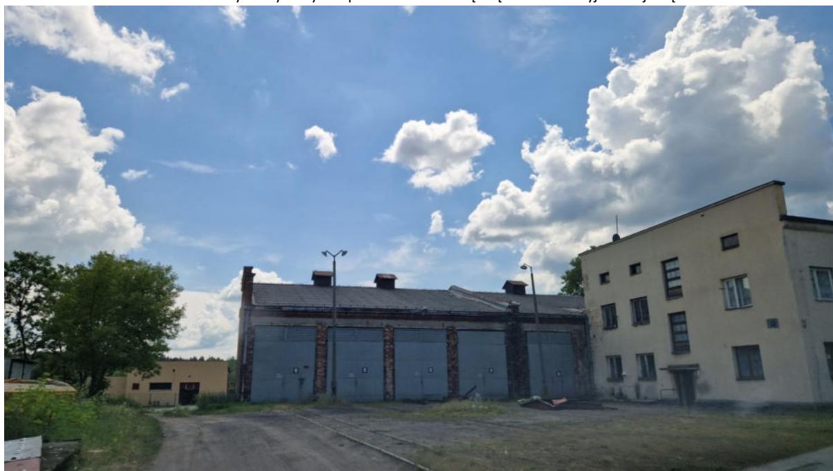
Fot. 2. Zabytkowy budynek parowozowni z częścią administracyjno-socjalną.
